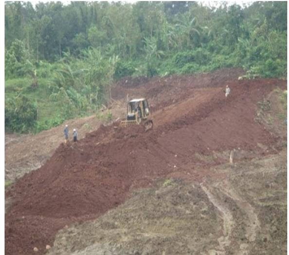
**Gambar 4.** Tanah Pengganti sebagai Tanah *Embankment Saddle Dam*
