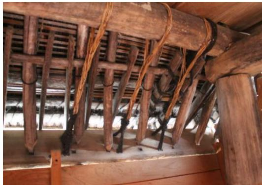
Gambar 12. Ikatan rotan pada bagian *bungkulon* dan *batahan* (Sumber: dokumentasi peneliti, 2018)
